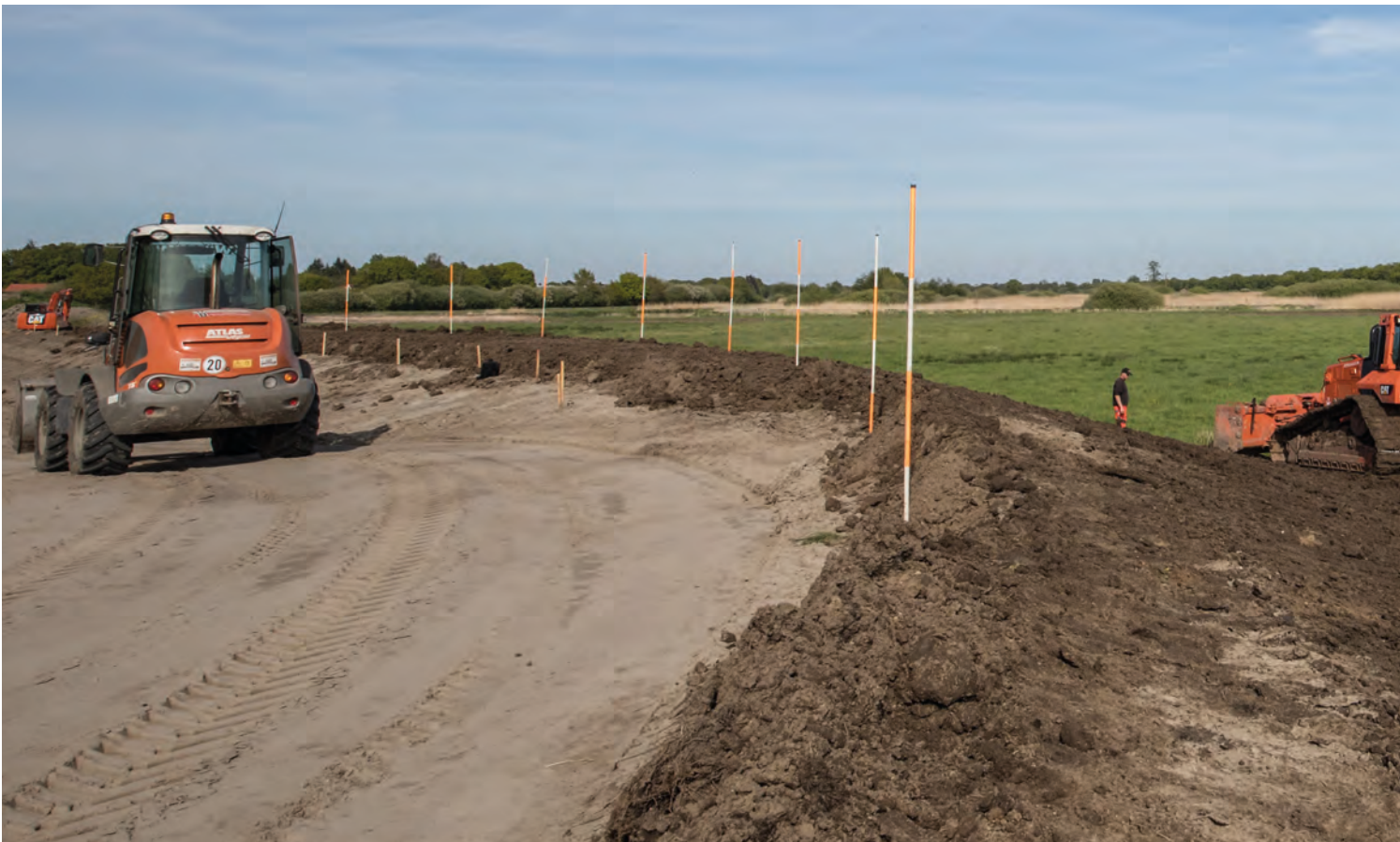
Abb. 8-1: Deichverstärkung und –rückverlegung am Aper Tief
