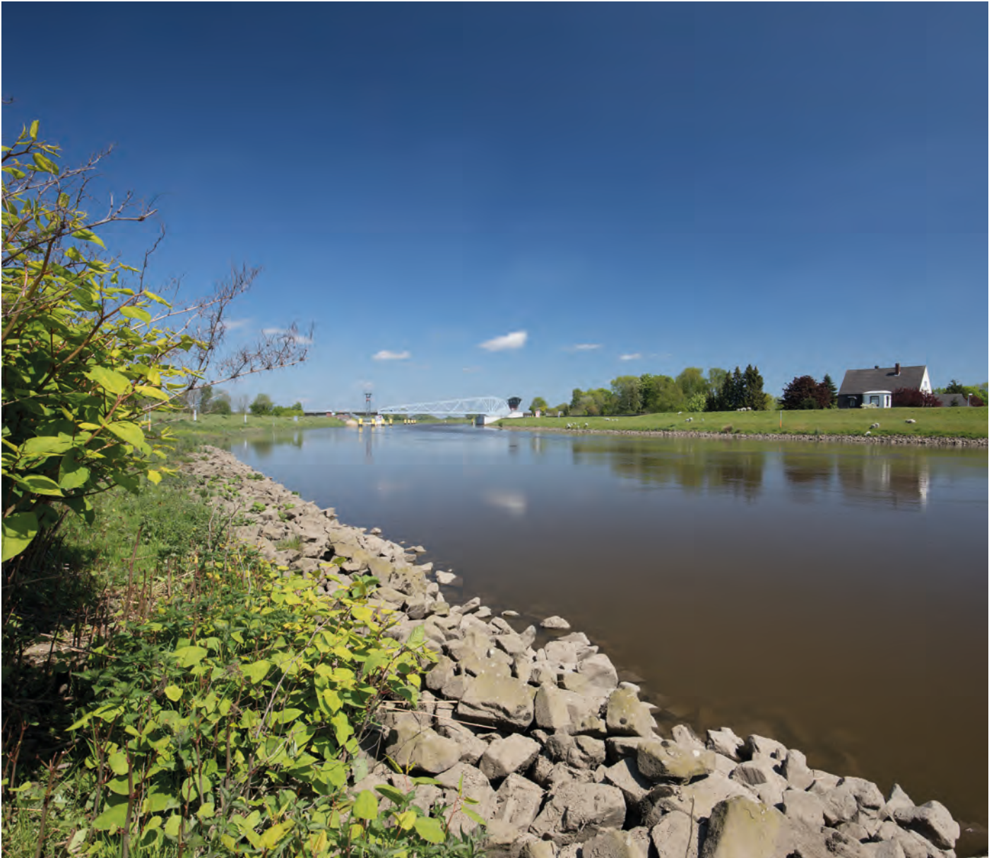
Abb. 6-5: Ufersicherung an einem scharliegenden Schutzdeich
