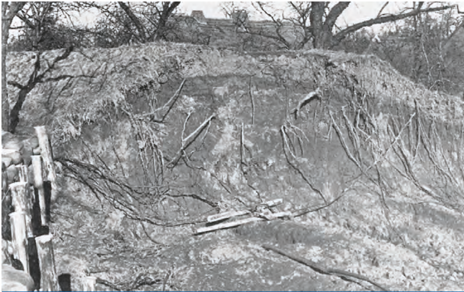
Abb. 1-2: Bruchstelle eines stark durchwurzelter Deiches im Alten Land im Februar 1962
