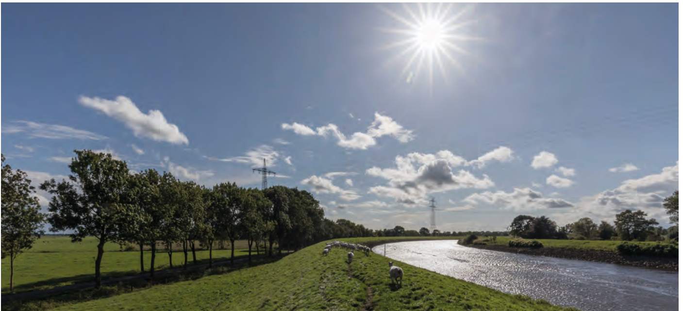
Abb. 2-2: Schutzdeiche an der Hunte unterhalb von Oldenburg
