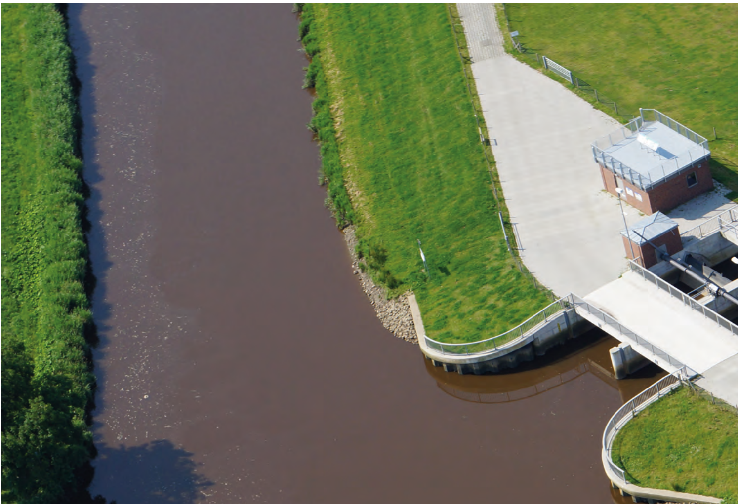
Abb. 6-2: Einlassbauwerk am Flutpolder Holter Hammrich
