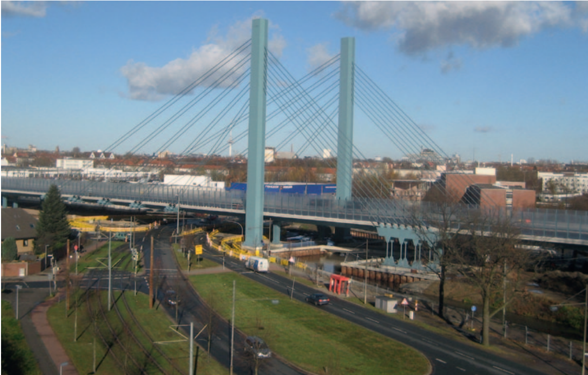
Bauabschnitt 2/1: Schrägseilbrücke über den Flughafendamm
