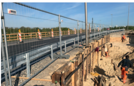
Bauvorbereitung der Brücke Carl-Benz-Straße
