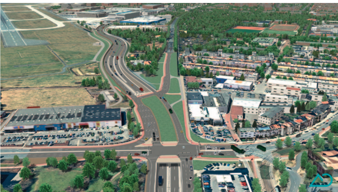
Tunnel und Trog mit Blickrichtung stadteinwärts
