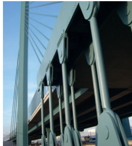
Zugverankerung der Schrägseile
