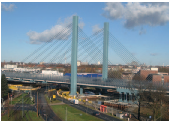
Bauabschnitt 2/1: Schrägseilbrücke über den Flughafendamm
