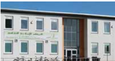
Gebäude des IKZ in Bremen-Mitte
