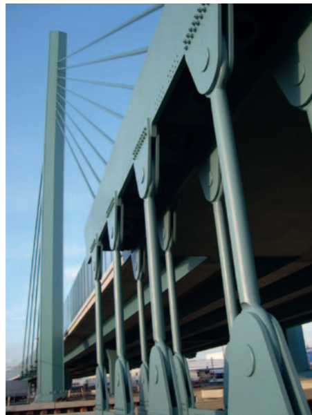
Zugverankerung der Schrägseile
