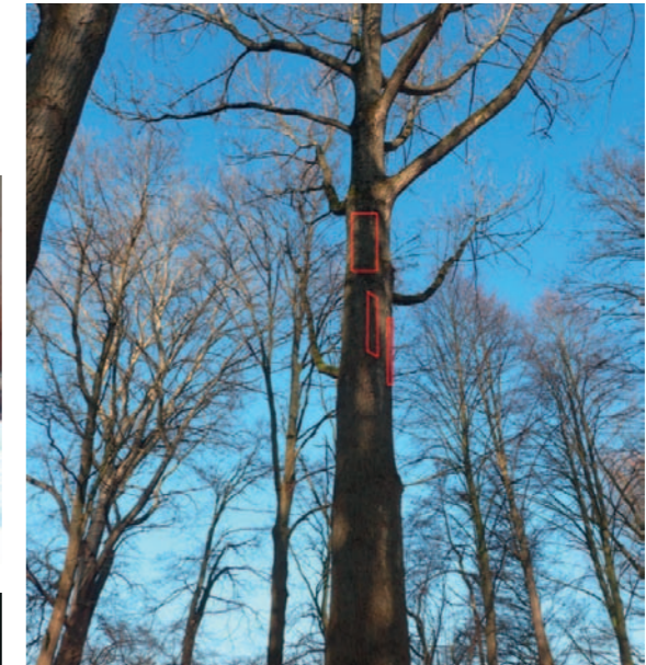
Vor Baubeginn vorgesehene Nisthilfen
