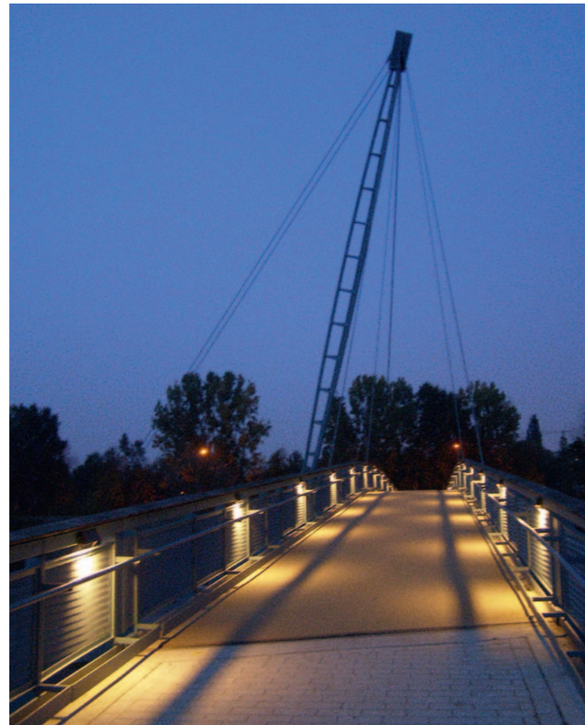
Bauabschnitt 3/1: Fußgängerbrücke im Zuge der Visbeker Straße
