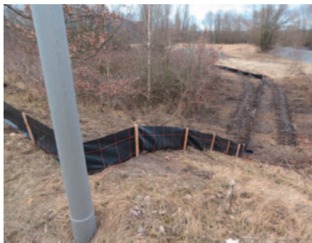
Vor Baubeginn aufgestellter Amphibienschutzzaun
