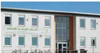
Gebäude des IKZ in Bremen-Mitte
