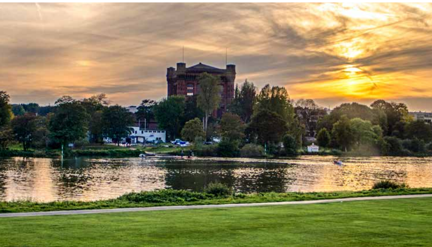
„Umgedrehte Kommode“ – ältester Bremer Wasserturm aus dem 19. Jahrhundert
