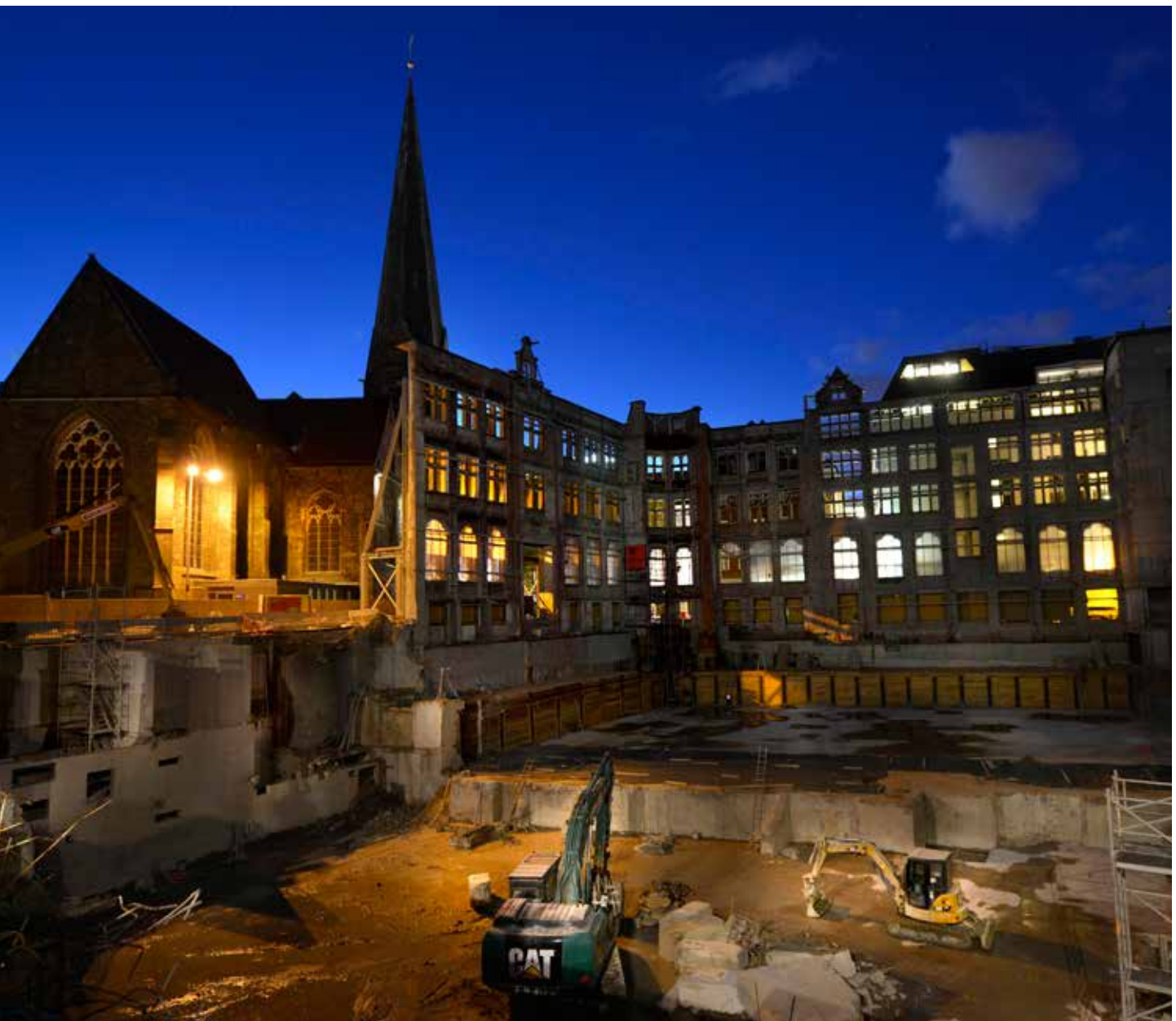
Bauarbeiten der Bremer Landesbank unter Erhaltung der historischen Fassade
