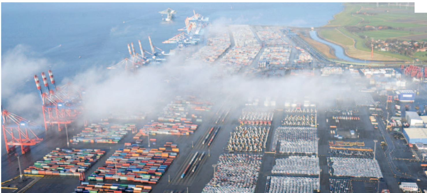
Containerterminal 4, Teil des Sondervermögens Hafen
