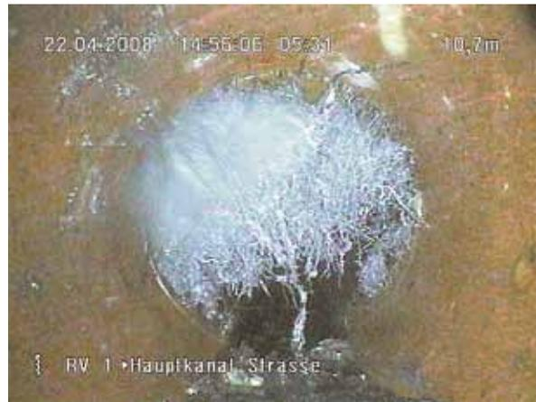
**Defekte Leitung – Schäden durch Wurzeinwuchs**
