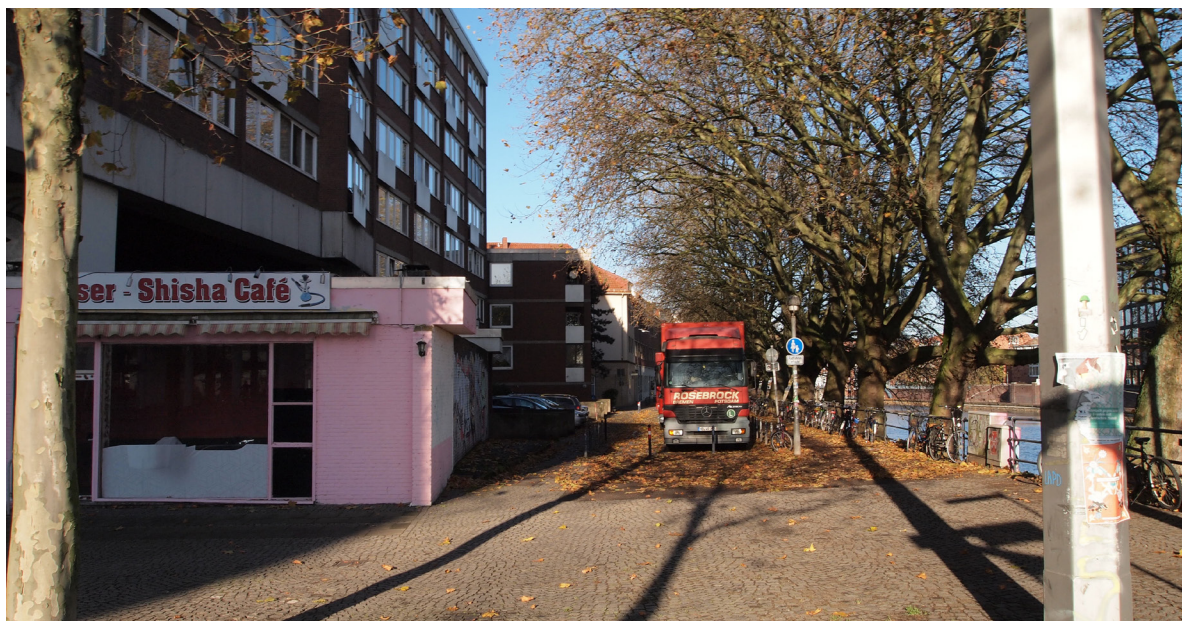
Ufersituation an der Straße „Am Deich“
