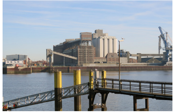
Getreideverkehrsanlage: Wichtigste Landmarke im Hafengebiet, Denkmalschutz seit 2006
