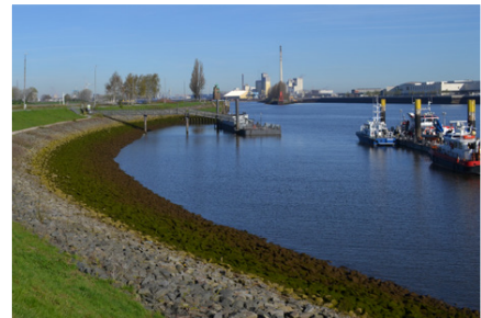
Steinschüttung am Wendebecken bei Tideniedrigwasser
