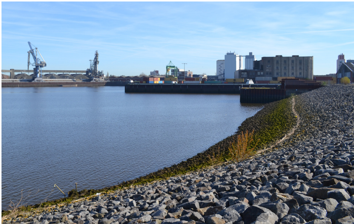
Steinschüttung am Wendebecken bei Tideniedrigwasser
